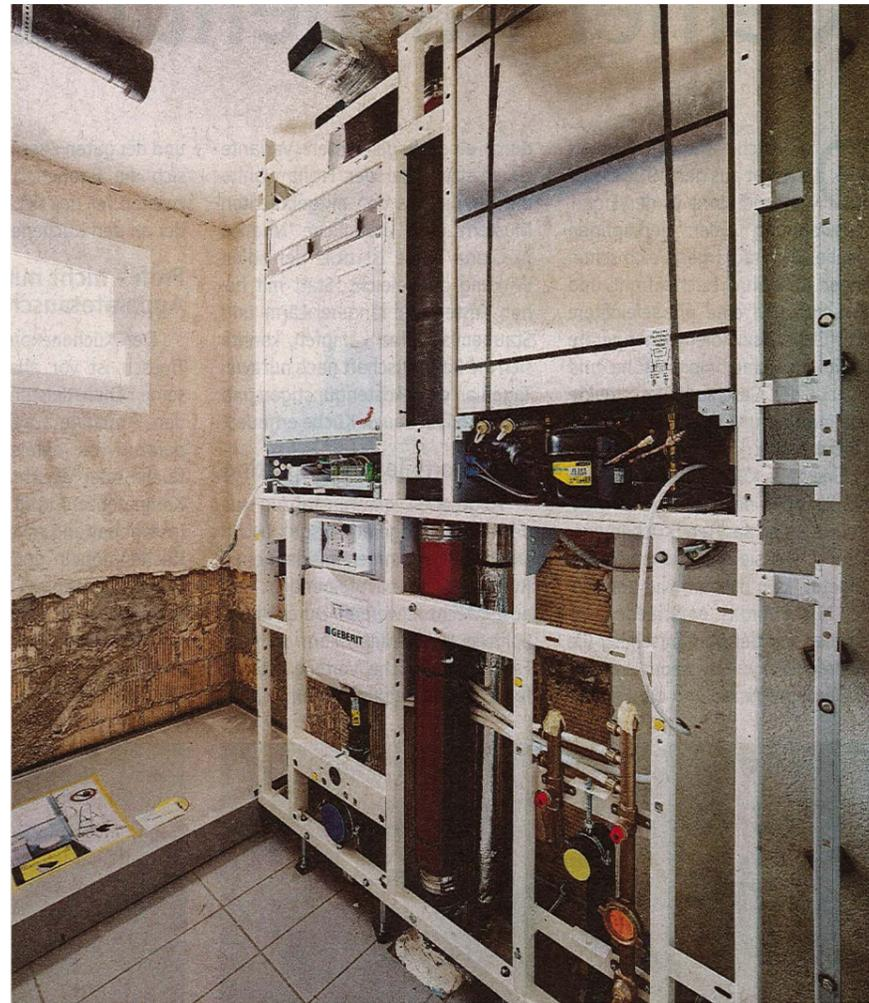
Nach Demontage der alten Badezimmer konnte das Vorwandssystem mit dem «Thermos» in kürzester Zeit montiert werden (oben). Die sanierten Badezimmer sind auf neuestem Stand und barrierefrei (unten).
